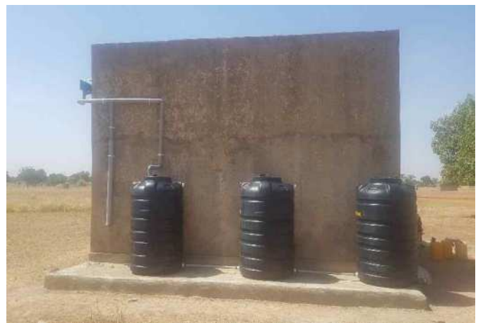
마을 센터 빗물 장치 설치 완료 모습
