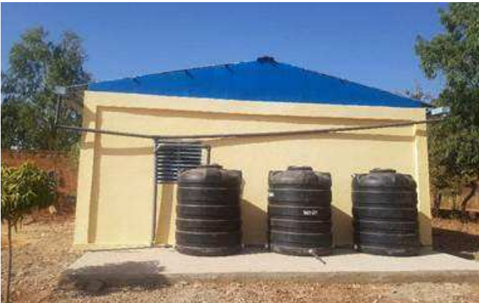
빗물시스템 장치 수용을 위한 ICC(일가가나안센터)내 다목적홀 건물 모습
